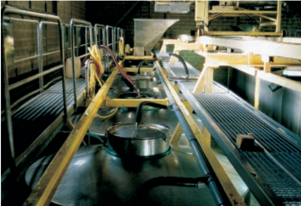
Exemple d'un réseau de captage du CO 2 à chaque point de production
